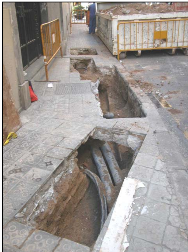
Vista general de la Rasa 100 en el tram paral·lel a la façana sud del carrer Duran i Bas.
