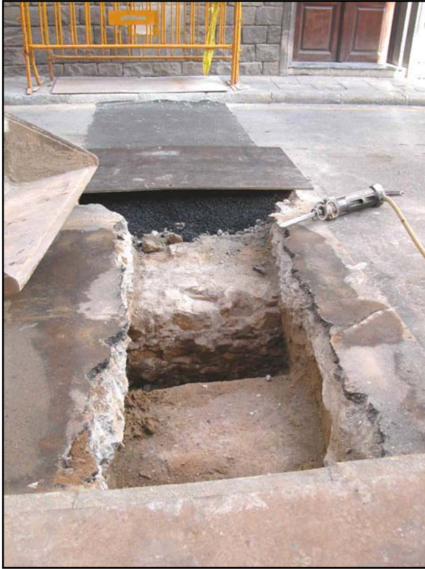
Rasa 100 tram perpendicular a la façana nord del carrer Duran i Bas. Vista general de la UE 103 abans de procedir al desmuntatge parcial.
