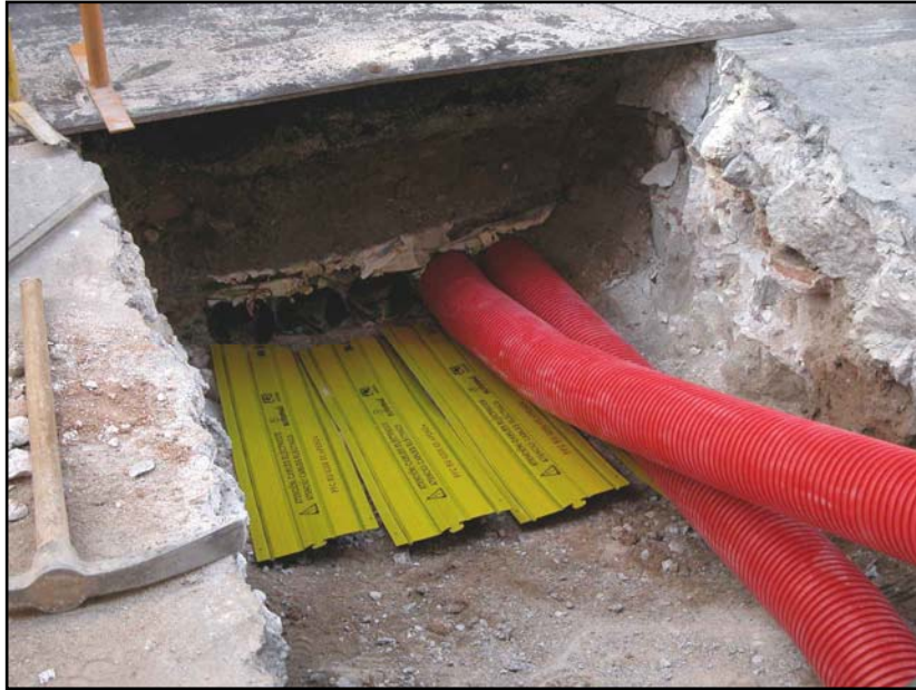
Protecció i senyalització de la UE 103 amb planxes de plàstic. Estesa de tubs per el cablejat elèctric.
