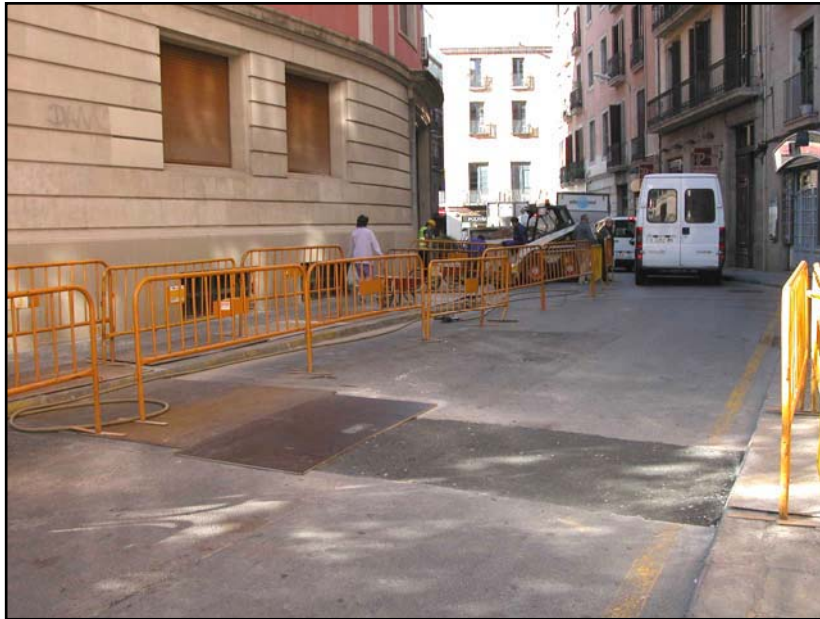
Vista general dels treballs al carrer Duran i Bas.
